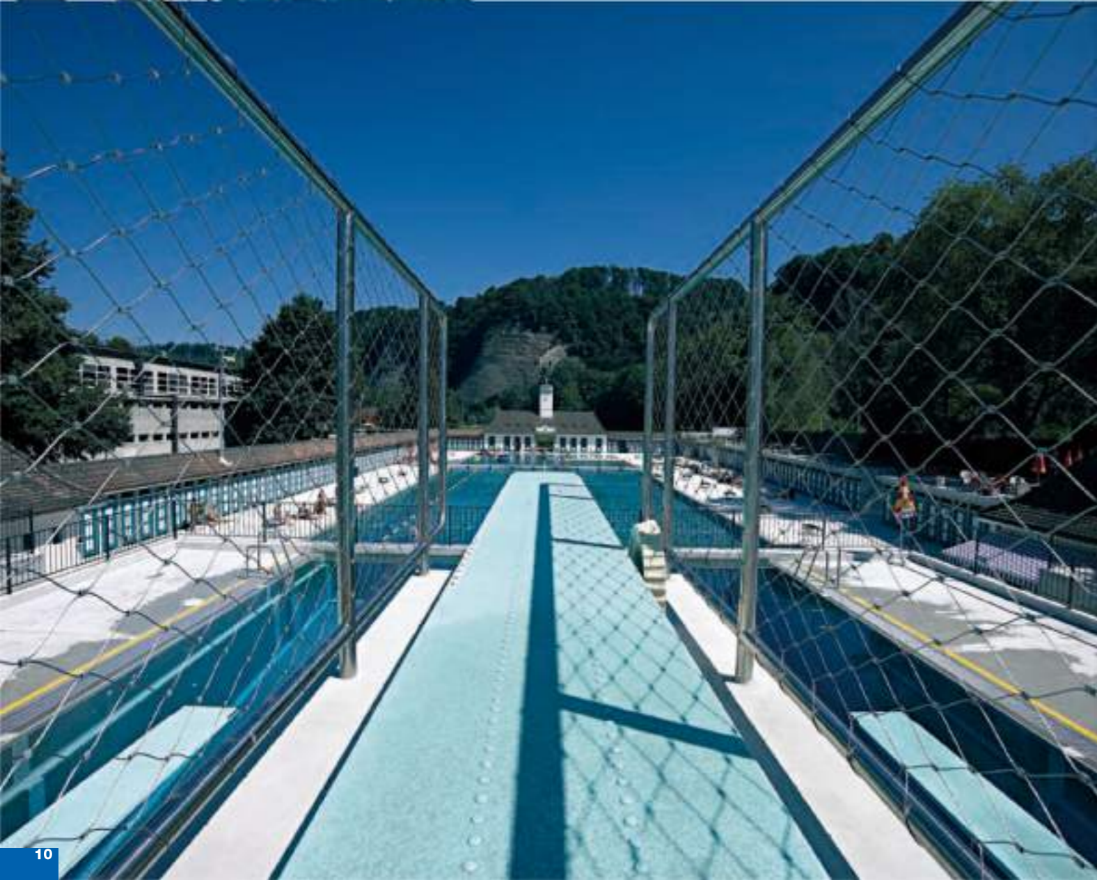
■ 야외 수영장의 다이빙 타워 • 웹넷 로프 \varnothing 1.5 mm, 메쉬 구경 100 mm ■ Diving tower, open-air pool • Webnet rope \varnothing 1.5 mm, mesh aperture 100 mm
