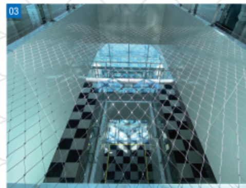
01 유진로봇 사옥 중정 YUJIN ROBOT 웹넷 추락방지 안전망 Webnet fall protection safety net
