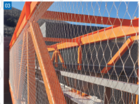
01 강원도, 하이원, 연결 다리 Connection Bridge, High1, Gangwon-do 웹넷 교량 난간 Bridge Safety, Webnet
