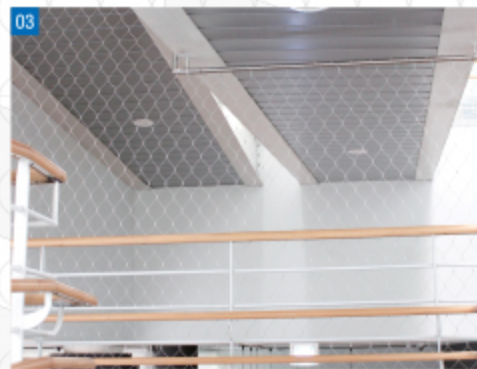
01 서초 한우리 정보문화센터 Hanwoori Information Culture Center 장애인 램프 구간 웹넷 Ramp section fall protection Webnet
