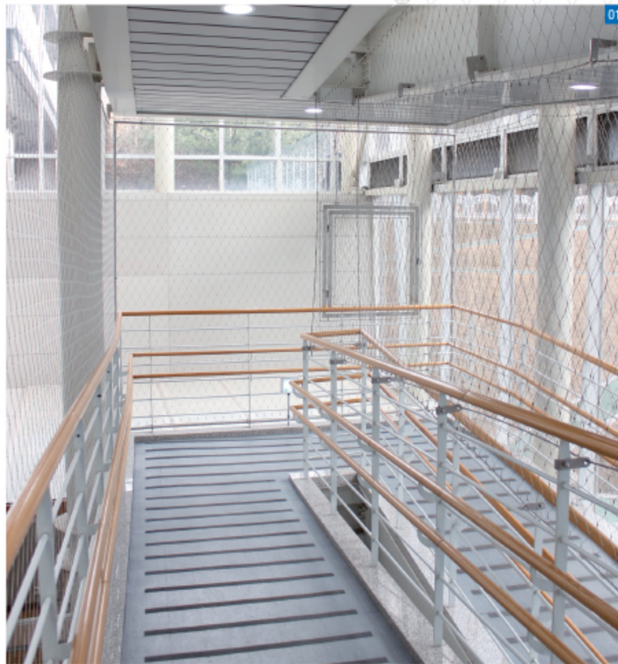
01 서초 한우리 정보문화센터 Hanwoori Information Culture Center 장애인 램프 구간 웹넷 Ramp section fall protection Webnet
