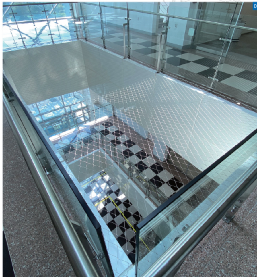
01 유진로봇 사옥 중정 YUJIN ROBOT 웹넷 추락방지 안전망 Webnet fall protection safety net
